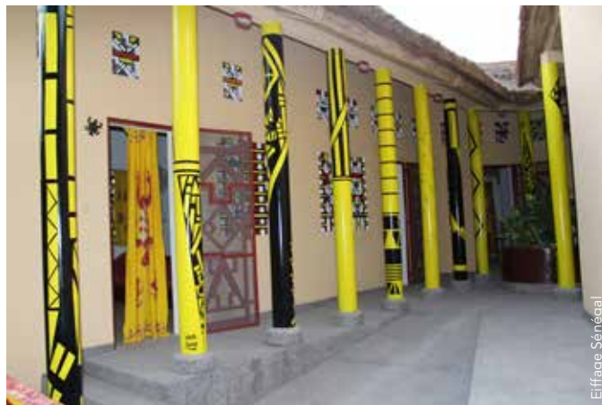
Eiffage Sénégal a financé une grande partie de la construction de la Maison des Artistes à Ziguinchor.
