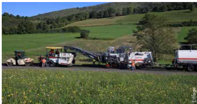
L'ARM 2500® en action (Eiffage Travaux Publics).
